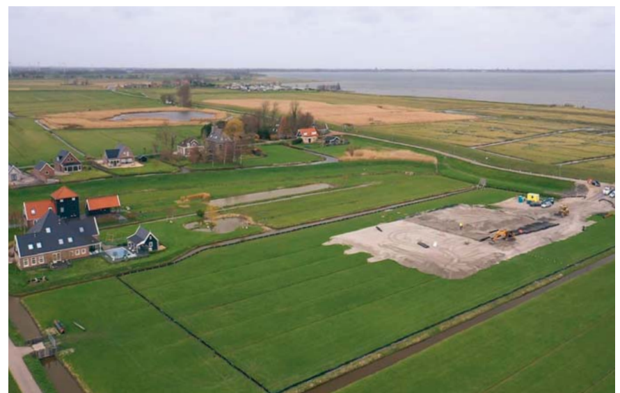
Figuur 2 – Opbouw van de proefterp bij Etersheim.
