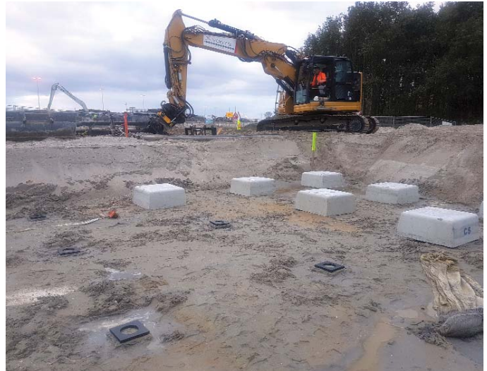
Figuur 13 – Links: weergave van de grootte van de heiknobbel op de geprefabriceerde betonpalen. Rechts: installatie van de paaldeksels op de paalkoppen met daar tussen het oplegrubber met opening.
